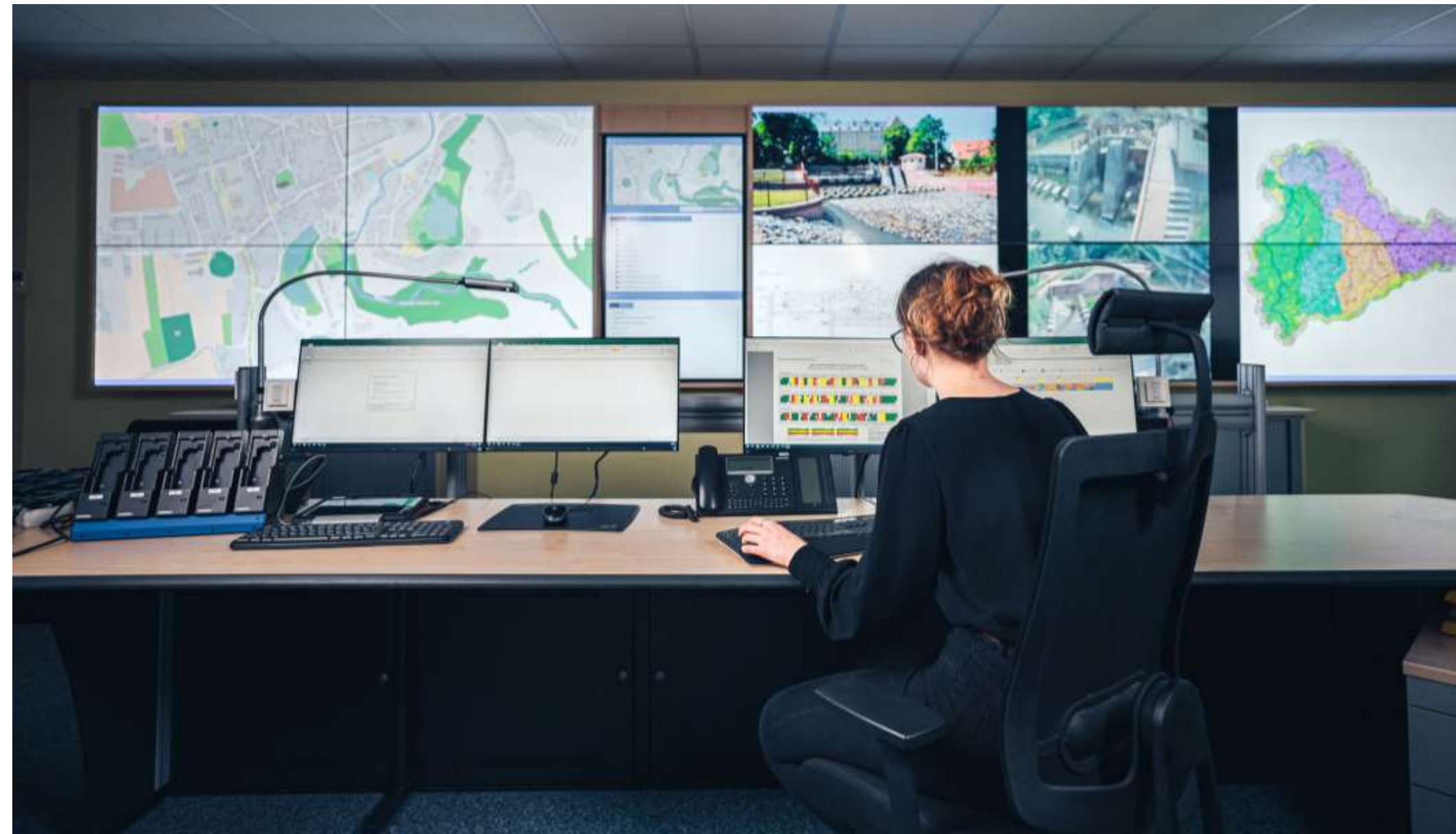
© Landestalsperrenverwaltung Sachsen – Fotograf: Tobias Ritz, Leitstand im Betrieb E/M/UWE
